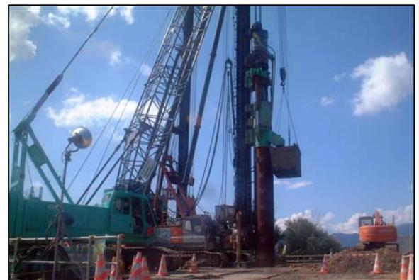
写真-3 鋼管の中掘り・圧入状況
