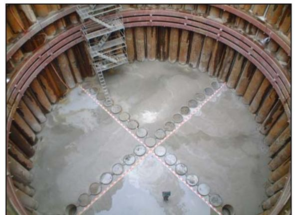
写真-4 鋼管矢板 掘削完了状況
